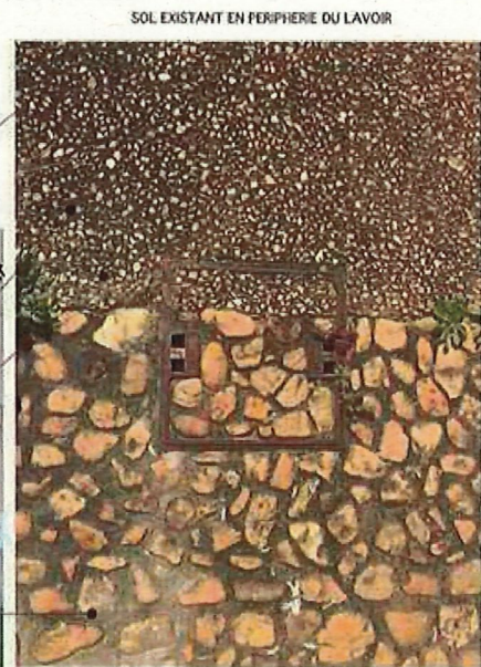
SOL EXISTANT EN PERIPHERIE DU LAVOIR
