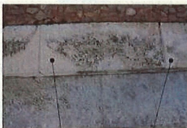
SOL EXISTANT EN PERIPHERIE DU LAVOIR
